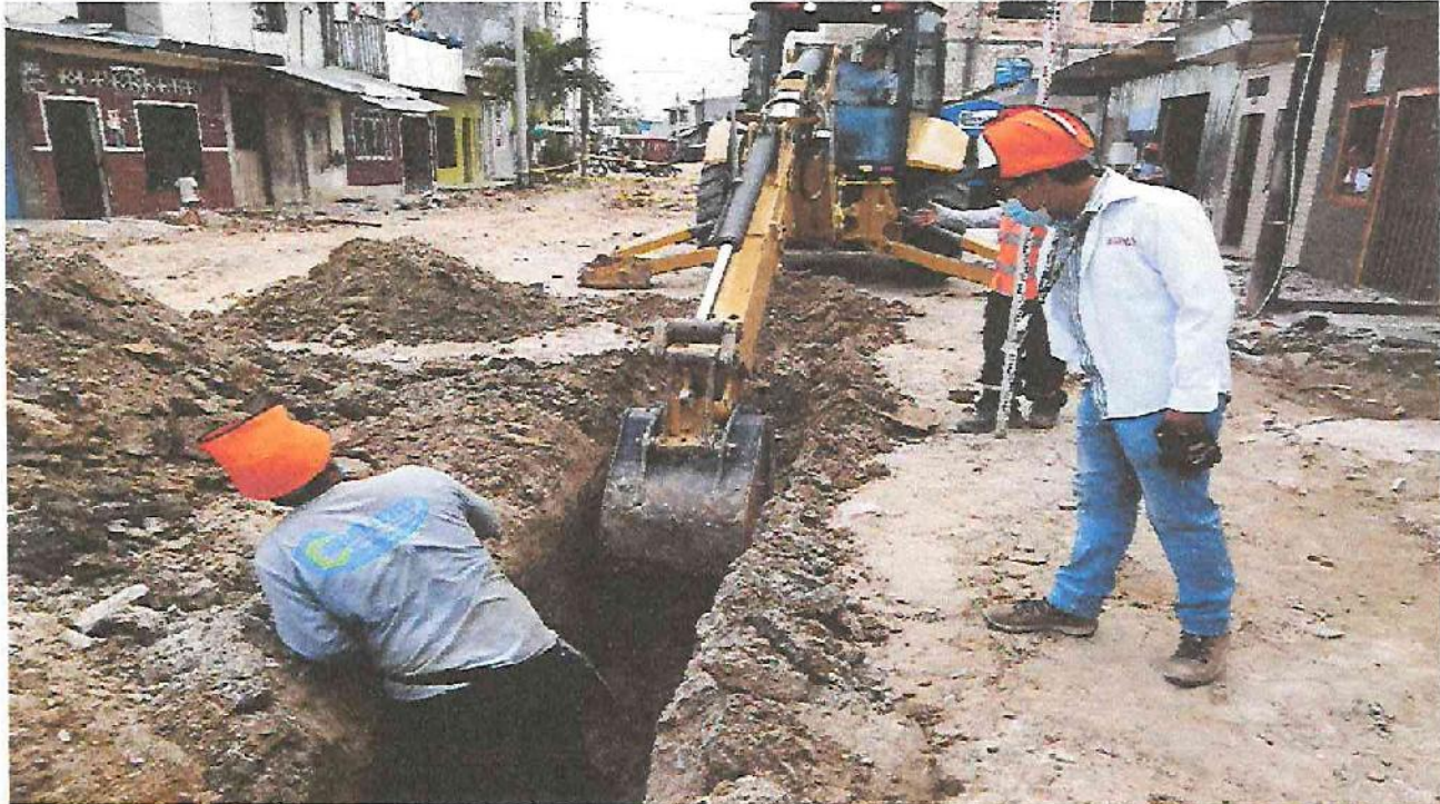
Foto: Suministro e instalación de tubería PVC SAL D=6". En Red Auxiliar.
