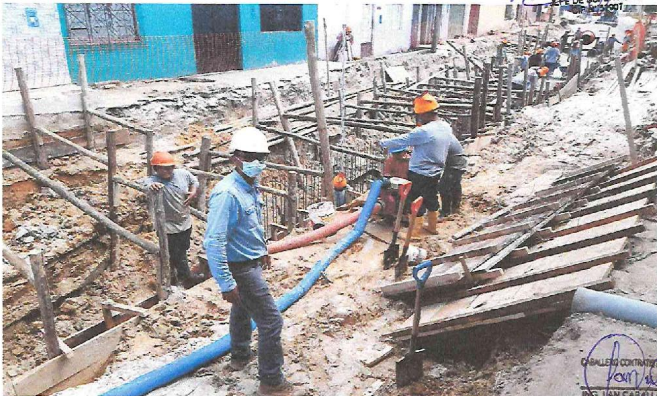
Foto: Se observa los trabajos de bombeo para la eliminación de Aguas filtrantes y pluviales Ca. Tahuantinsuyo.
