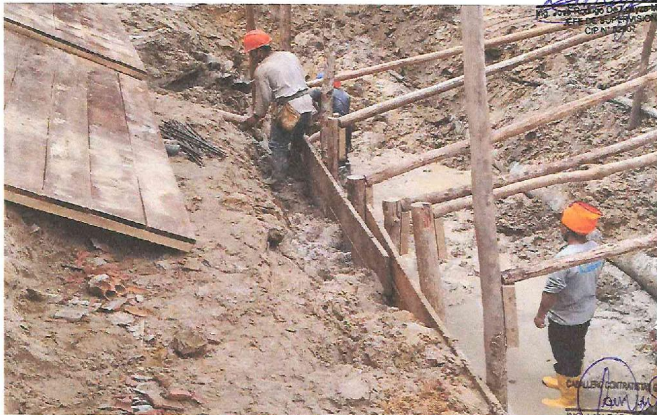
Foto: Vista de los trabajos de entibados para protección de Excavación Tramo 2 Ca. Tahuantinsuyo.
