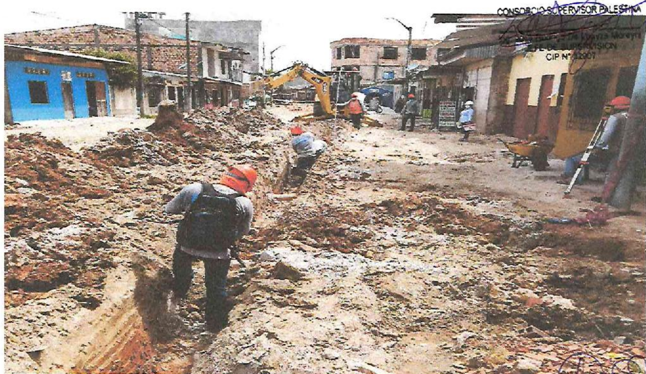
Foto: Excavación manual de Zanja para Desagüe Auxiliar.
