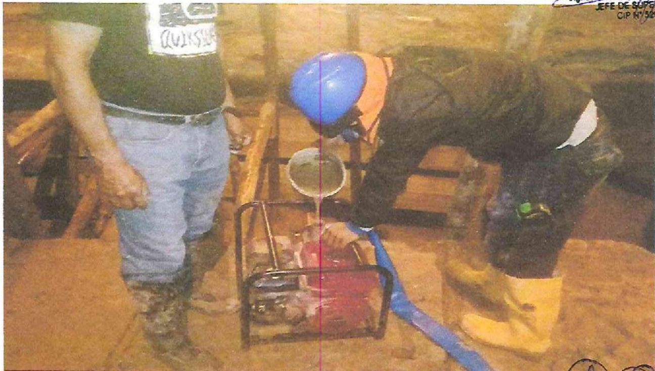
Foto: Trabajos de bombeo para la eliminación de Aguas filtrantes y pluviales Ca. Tahuantinsuyo.
