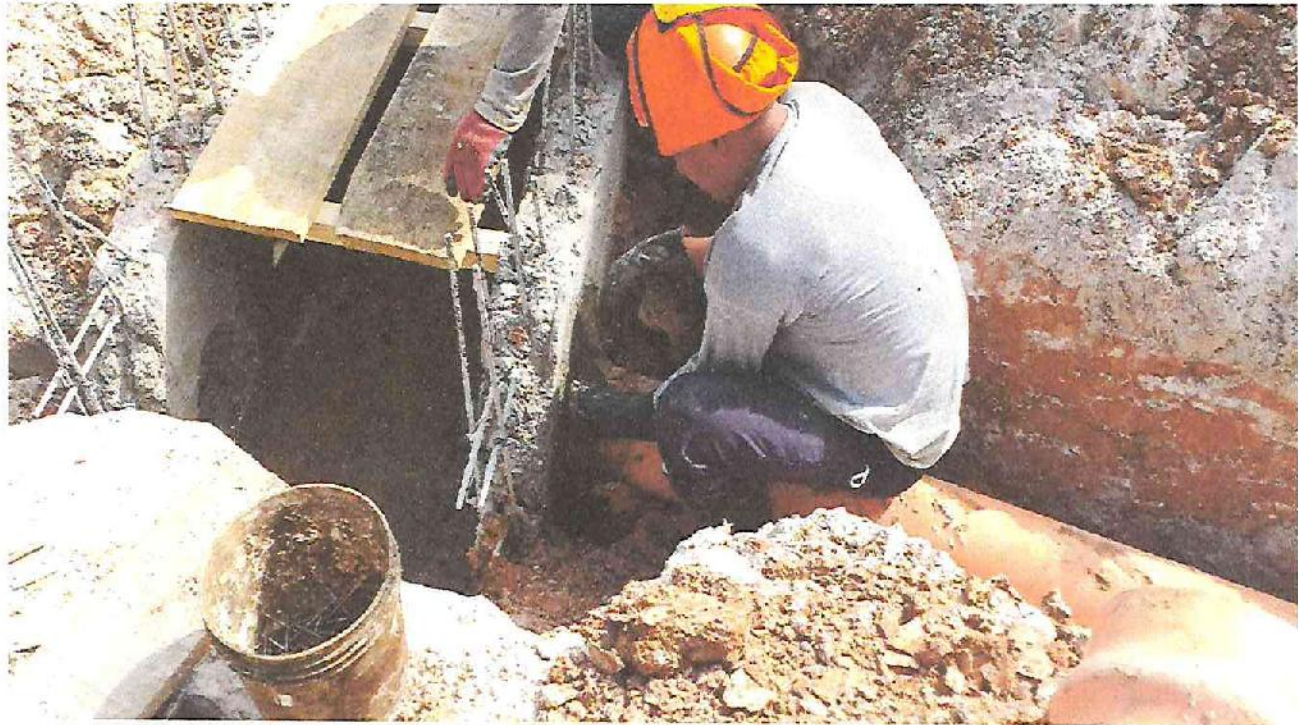
Foto: Excavación manual de Zanja para Desagüe Auxiliar.
